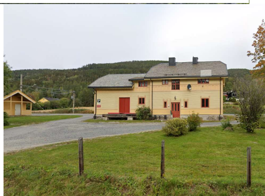
Figur 16 Flå stasjon langs Bergensbanen. Foto: Google.
