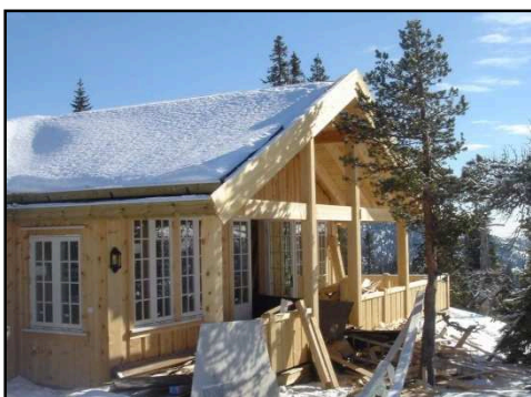
Hyttebygging Høgevarde – foto Re Plan
