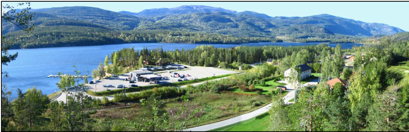
Oversiktsbilde Hallingporten – arealet avgrenser seg mot fjorden i bakkant, mot riksveien foran bensinstasjonen og strekker seg et stykke oppover – foto Vidar Seterstøen
