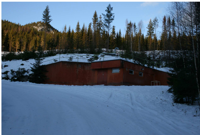
Figur 1. Flå Vannverk og Høydebasseng
