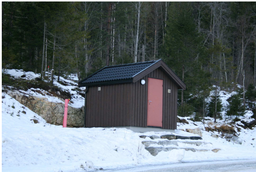
Figur 4. Vannpumpestasjon Tunnelen II
