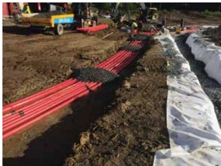
Det ble mange meter med rør..
