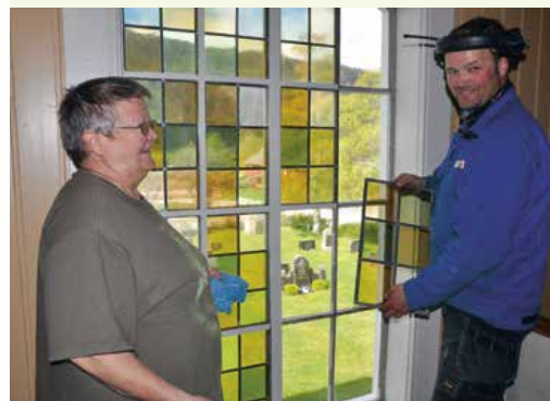
På bildet ser vi Kjetil Leikvoll fra Strendo Trevere med en del av et blyglassvindu, og klokker Karin Reiersgård som hjalp til med vinduspuss etter som seksjonene ble satt inn igjen.
